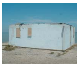
la cabane sécurisée, avant sa réhabilitation
