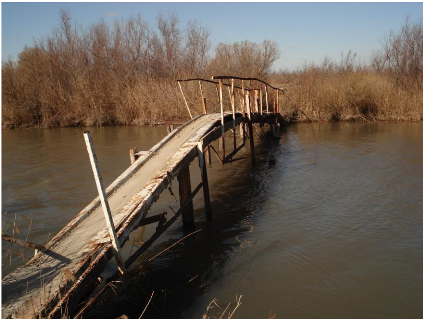
Fig 3. Ouvrage en place à démonter et évacuer
