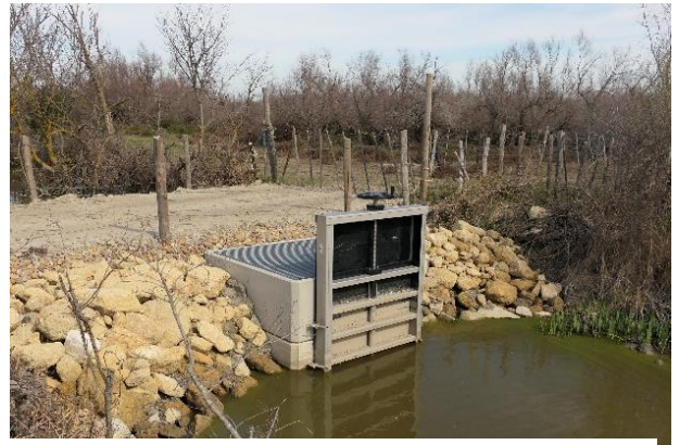
Illustration 4 : Suivi des travaux hydrauliques Belugue ©Le Borne, PNRC 2023
