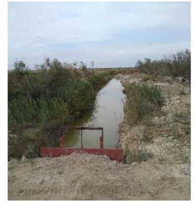
Illustration 41 : Travaux hydrauliques Rousty © L. Poulet PNRC 2023
