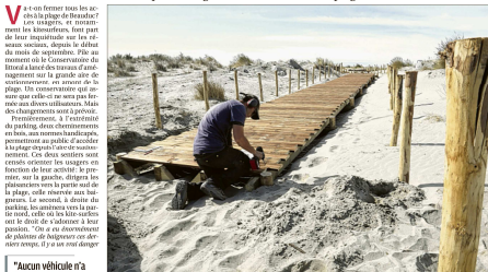
Les travaux, qui ont commencé le 4 septembre, devraient durer encore une semaine, si tout se déroule comme prévu. /PHOTO VALÈS FARIER
