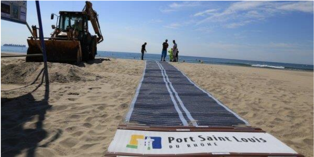
Figure 13: accès pour personnes à mobilité réduite (Source : site internet de la ville de Port-Saint-Louis-du-Rhône)
