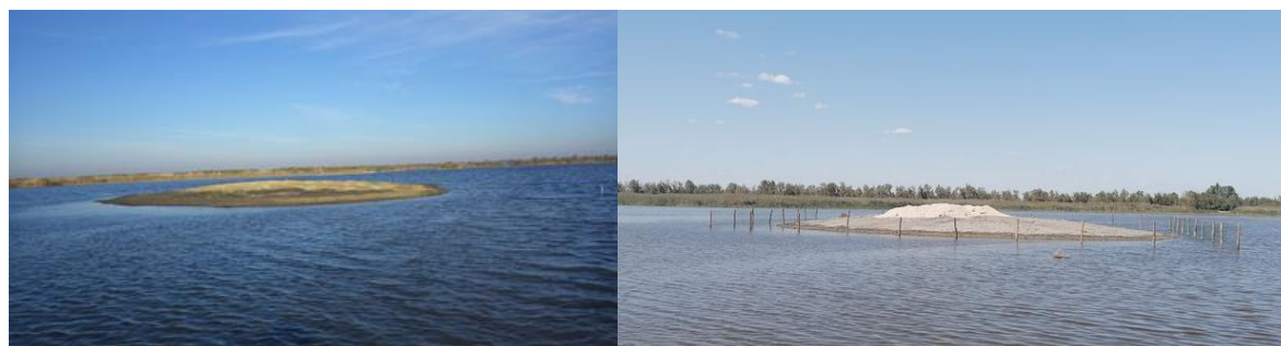
Photographie des îlots des Grandes cabanes Sud (SIG_4 et SIG_6) en 2016 et 2021 après leur construction.
